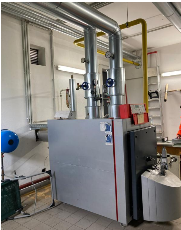
Abbildung 1+2 : Gaskessel + Pufferspeicher
